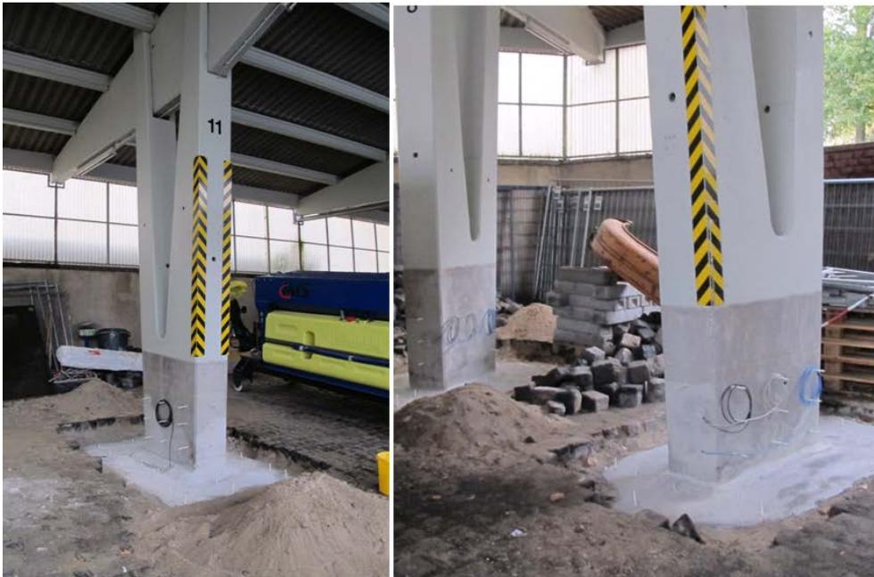
Abb. 42: Instandgesetzte Stützen mit isolierendem Überzug und Anschlussbewehrung
