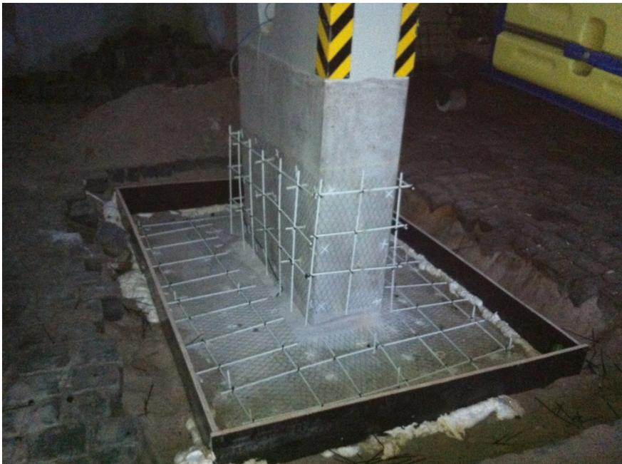
*Abb. 44: Bewehrung des Aufbetons bei Verwendung einer MMO-Anode*
