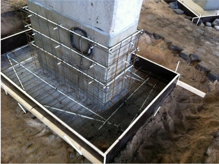
*Abb. 43: Bewehrung des Aufbetons bei Verwendung leitfähiger Beschichtungen*
