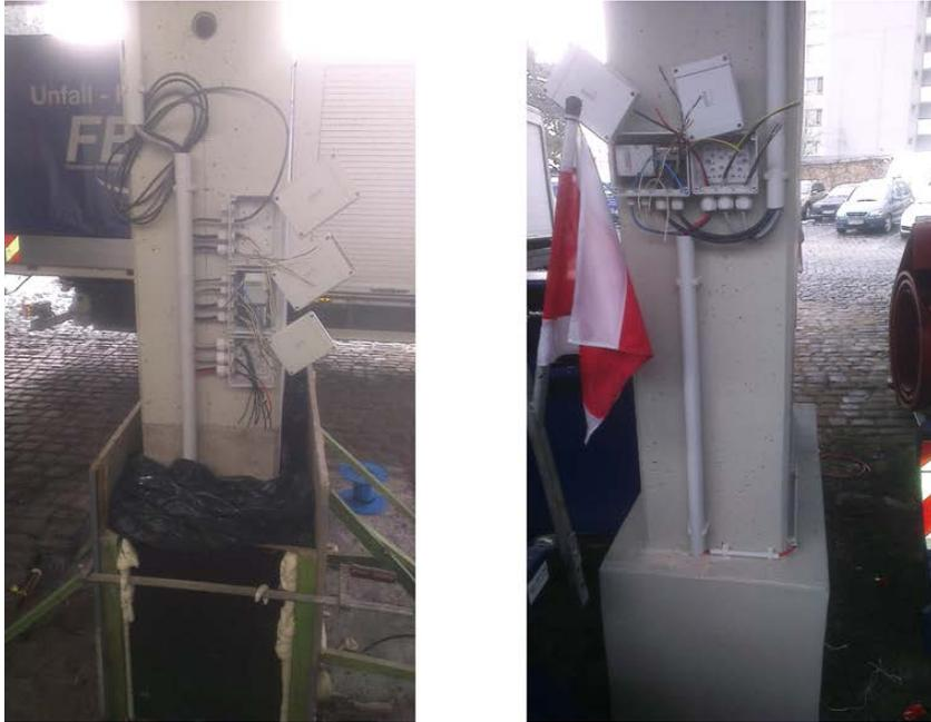
Abb. 45: Stützenfüße mit Aufbeton in Schalung (links) und fertiggestellt (rechts)
