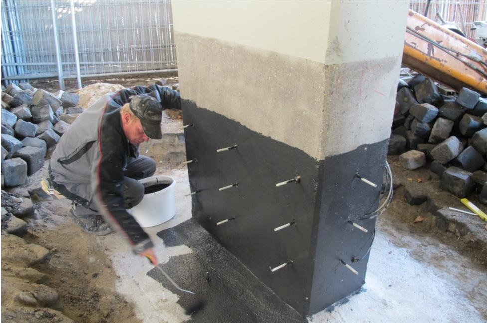
Abb. 41: Applikation einer leitfähigen Beschichtung
